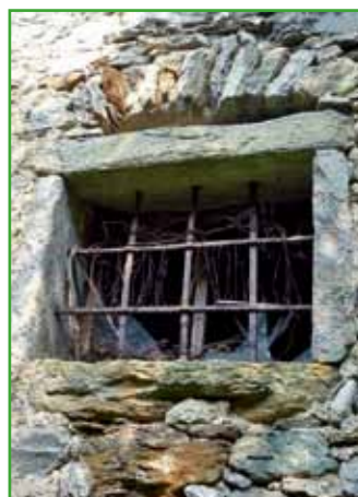
Dettaglio dell'apertura di un edificio di civile abitazione nel borgo di Veglio (Montecrestese, VB). I montanti, il davanzale e l'architrave sono realizzati con elementi monolitici in pietra. Sovrastante l'architrave è disposto un arco di scarico, con elementi in pietra di "coltello", allo scopo di diminuire le sollecitazioni gravanti sull'architrave medesimo.
